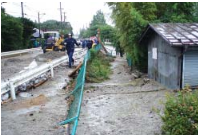
平成18年7月豪雨による被害状況(伊那市内)
